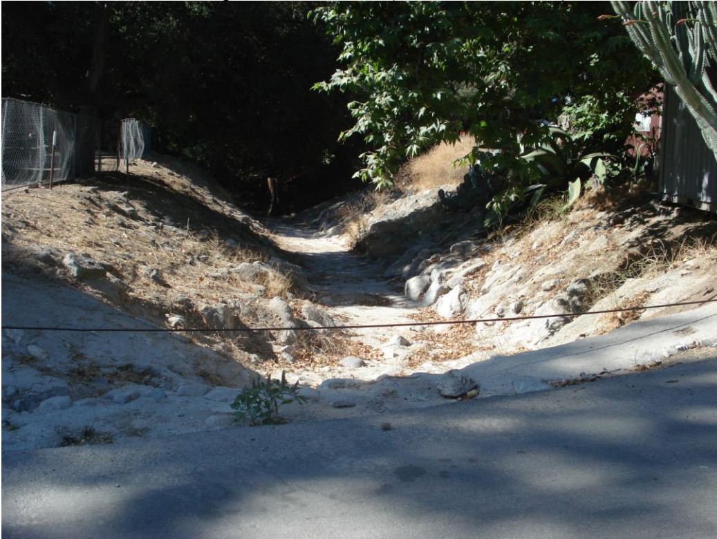
Looking d/s Sta. 61+75 (HEC-RAS Model)
