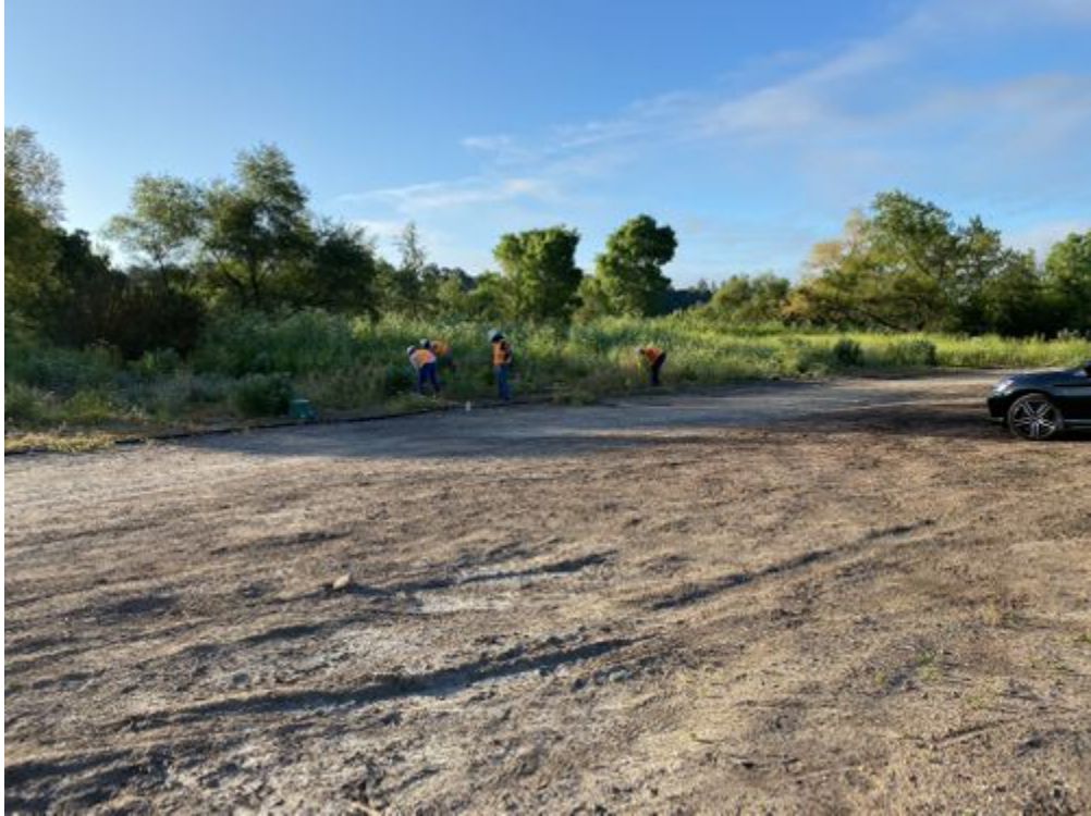
Weed clearing DG-4.jpg -118.17523 34.19247
