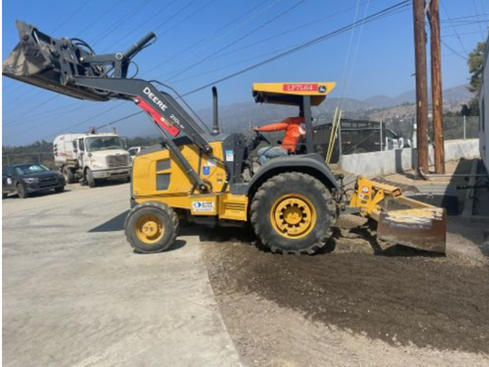
Skip_loader_moving_and_scraping_dirt_ramp_091721.jpg -118.17358746111111 34.18520454722222
