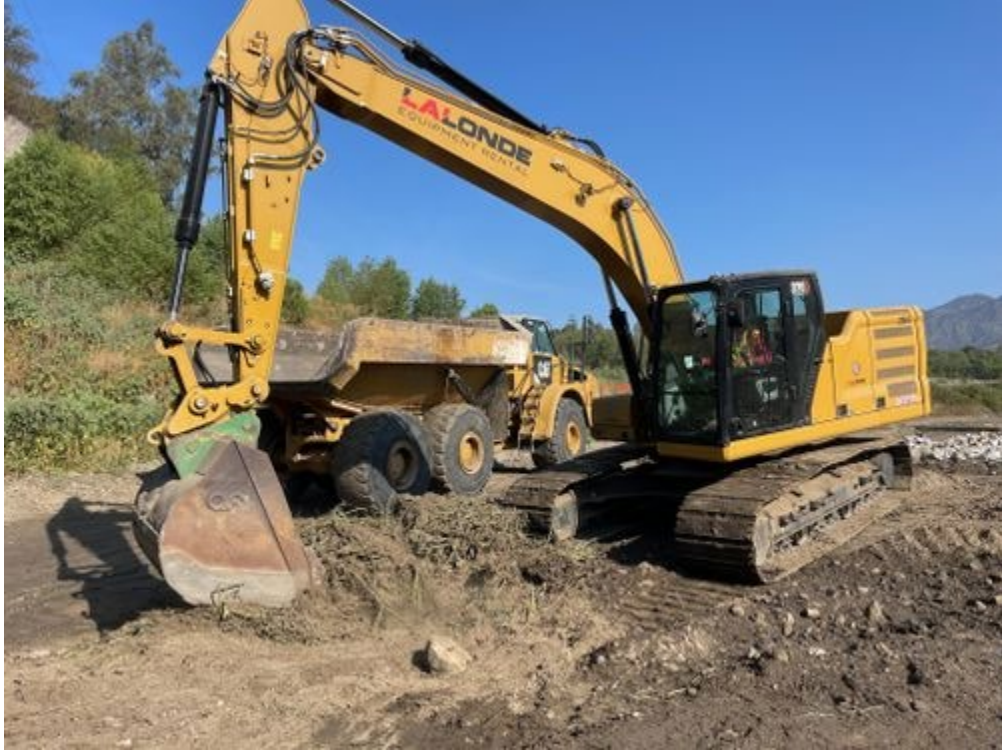
Removing veg piles_072321.jpg -118.17514448333334 34.18574161944444
