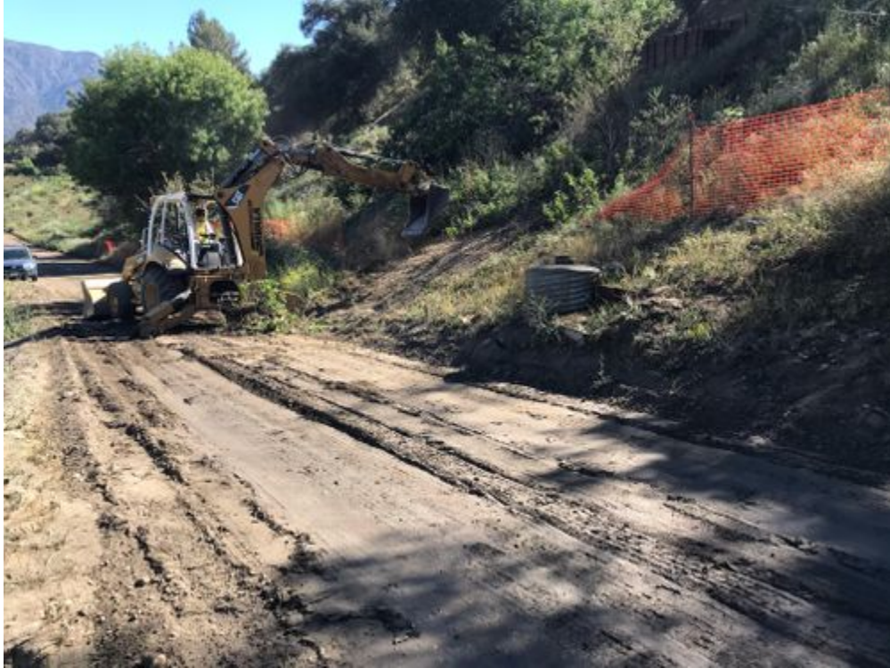
04-29-21_front_loader_removing_vegetation_near_restoration_area.jpg
